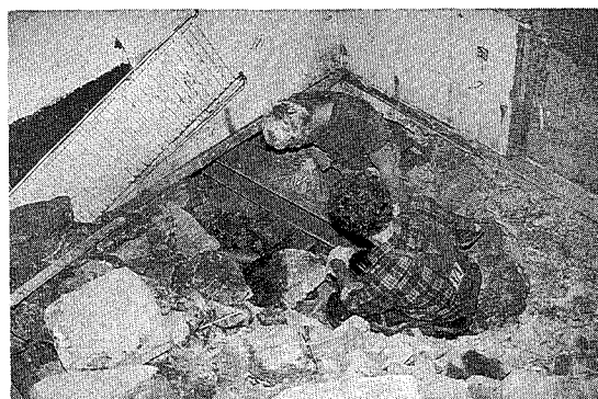
Vid en arbetsplats höll man på med grundförstärkning av en fastighet i centrala Göteborg.
